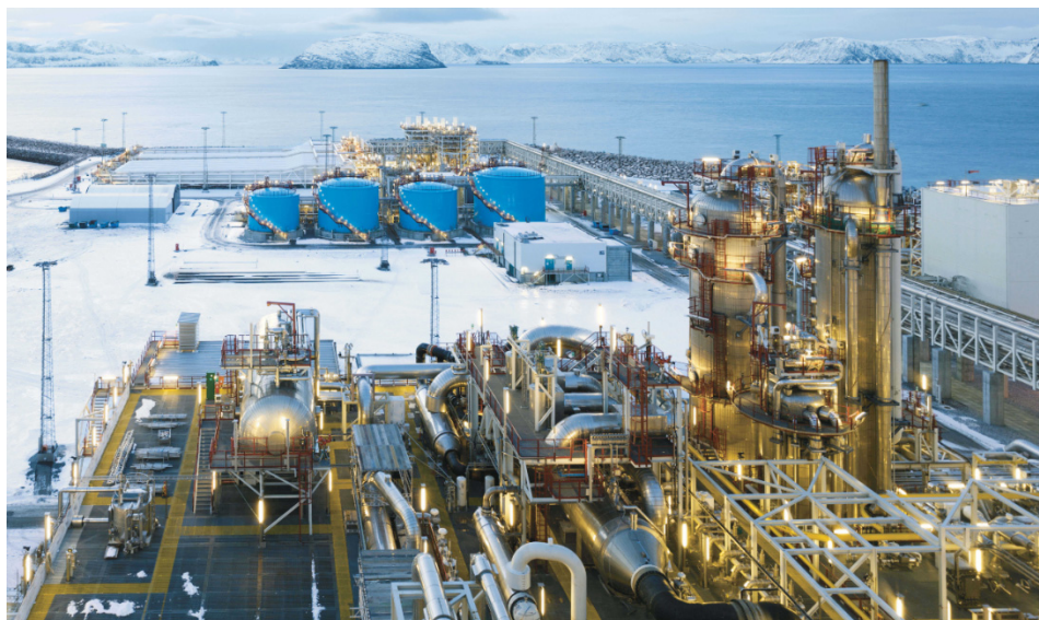
Bildunterschrift: Onshore Erdgasaufbereitungsanlage (©The Linde Group).
