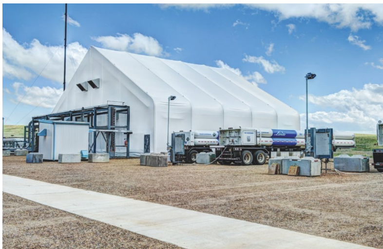
Bildunterschrift: Von Linde gebaute Anlage zur Heliumaufbereitung in Mankota, Kanada. Rechts im Bild sind Helium-Tube-Trailer zum Kundentransport des Edelgases zu sehen. (Quelle: The Linde Group).
